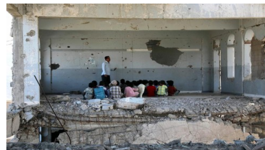
Le 3 septembre 2019, jour de la rentrée scolaire, des enfants assistent à un cours dans leur école qui a été endommagée par une frappe aérienne lors des combats entre la coalition menée par l'Arabie saoudite et les forces houthis, à Taïz au Yémen. © 2019 Ahmad al-Basha/AFP/Getty Images
